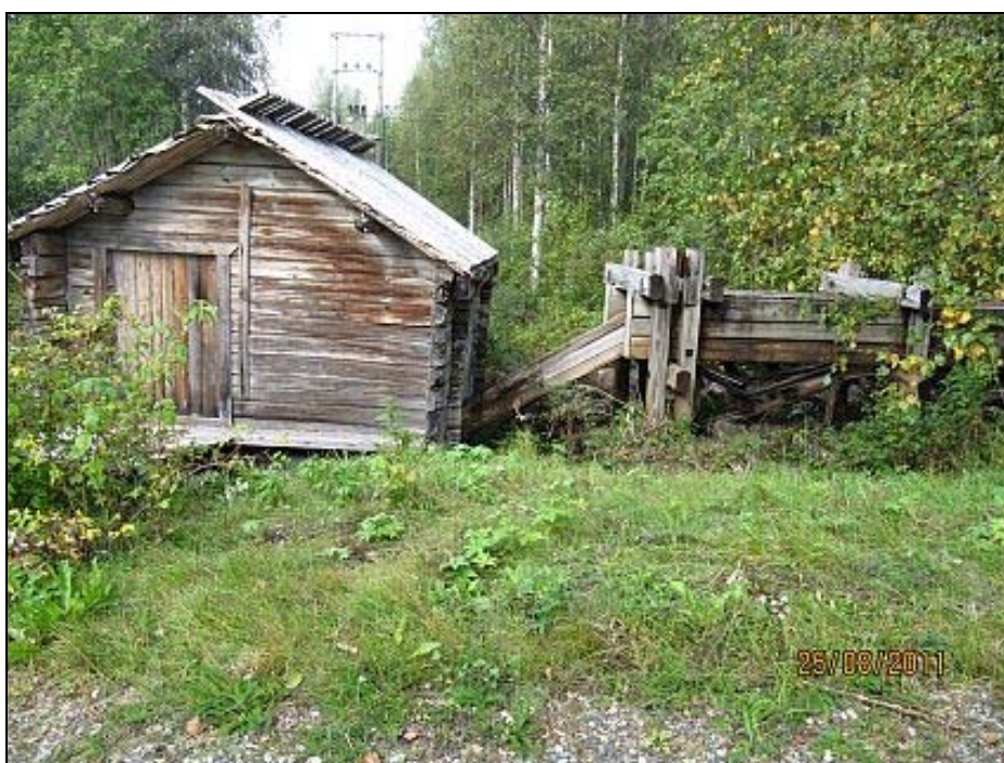
Kuva 23. Raivauksen jälkeen paljastunut kunnostusta kaipaava mylly.
