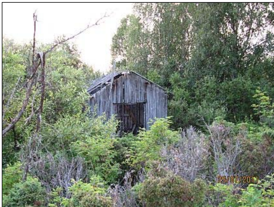
Kuva 8. Hirvasojan virkistysalueen ainoa pystyssä oleva lato.
